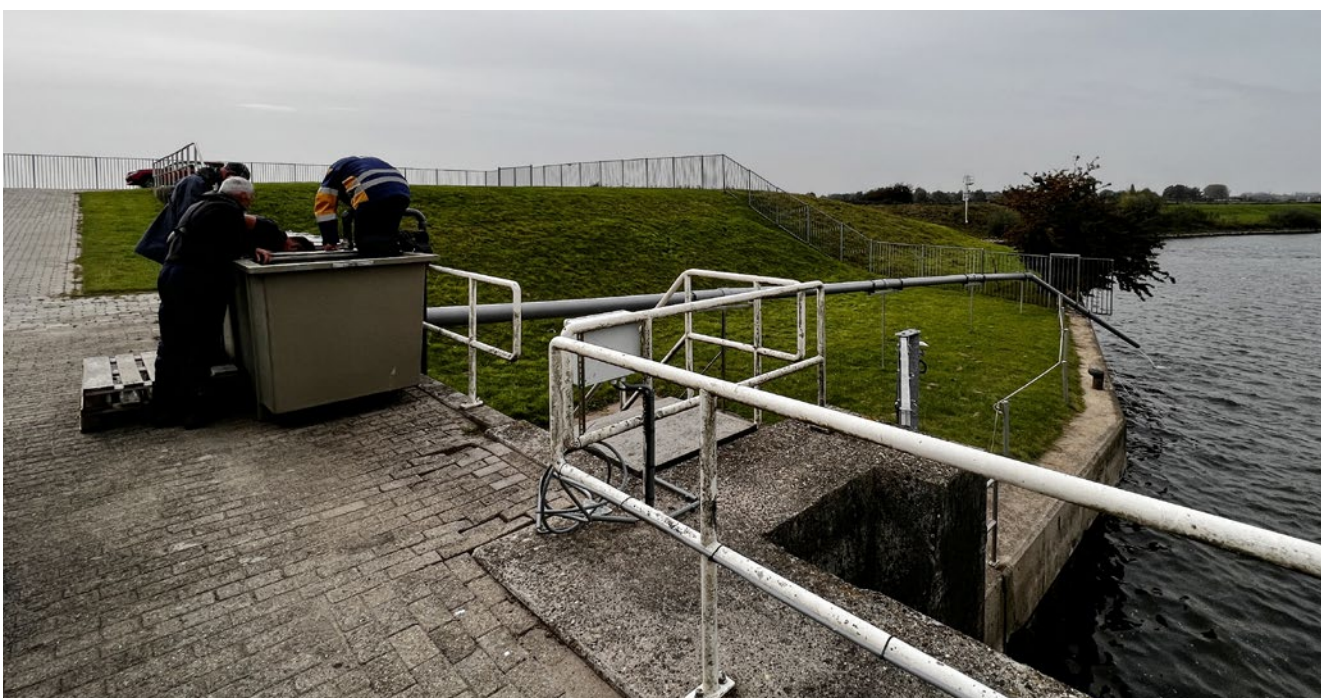
De nieuwe migratie-installatie bij Maurik
